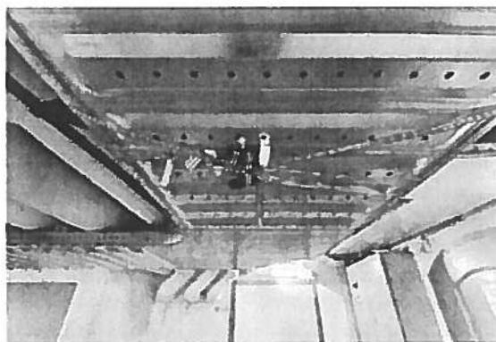
noodmaatregelen overvolle kabelgoten Eerste Kamer
