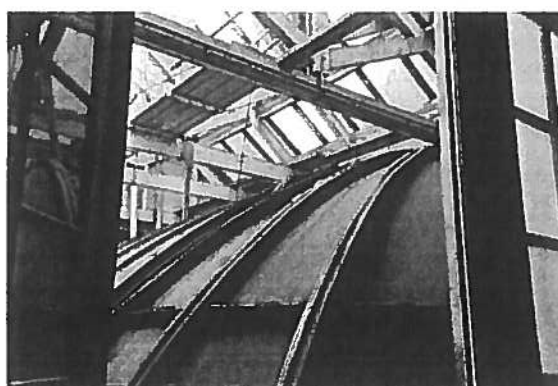
ontbreken brandscheidingen boven plafond centrale hal Eerste Kamer
