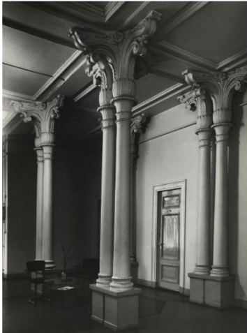
Gietijzeren kolommen (1860) op 1 e verdieping. De vide is op deze foto al dichtgelegd.
