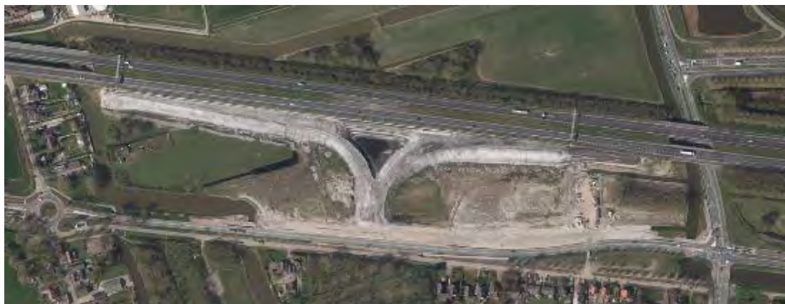
Figuur 4.22 Luchtfoto werkzaamheden aanleg afrit 7, 2016 (bron: Globespotter)
