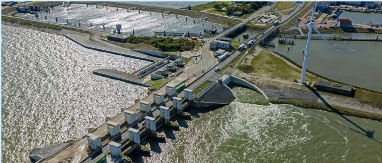
Spuisluizen Den Oever. Foto: Rijkswaterstaat/Droneview
