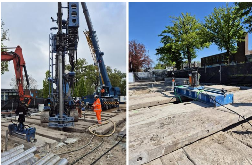
Ankerpalen bezwijkproef voor Tunnel
