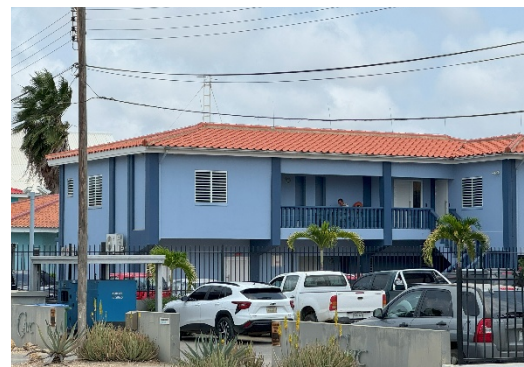
Figuur 1: Datacenter SSO-CN Bonaire
