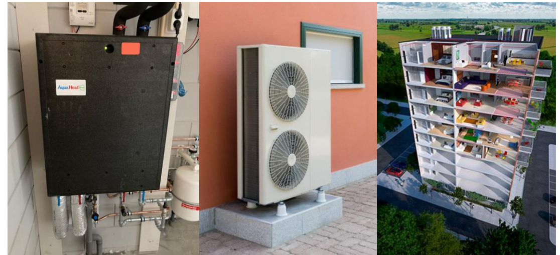
Figuur 5.9 Ruimtelijke inpassing warmteoplossingen in woning (v.l.n.r.): Afleverset, buitenunit warmtepomp, collectieve aansluiting
