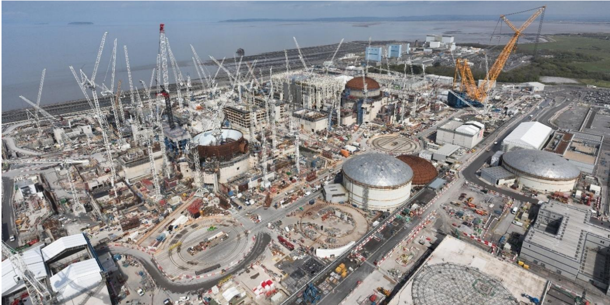
Figuur 3-6: Voorbeeld indicatie bouwfase (EDF); Hinkley Point C (bron: EDF energy, 2024) Het totale werkterrein is hier ongeveer 175 hectare groot, waarvan ongeveer 20 hectare voor grondopslag en ongeveer 5 hectare voor een hoogspanningsstation.
