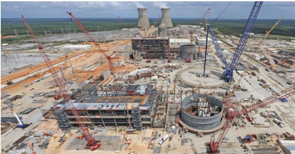
Figuur 3-7: Voorbeeld indicatie bouwfase (Westinghouse); Vogtle Units 3 & 4 (bron: Westinghouse Nuclear).
