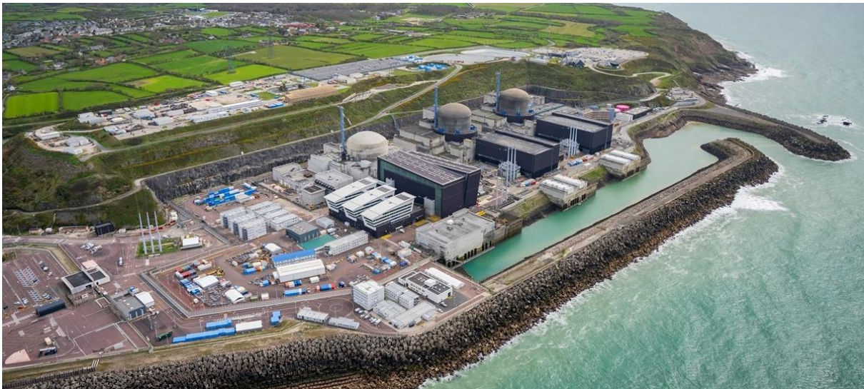
Figuur 3-4: Voorbeeld bedrijfsfase; Flamanville (bron: EDF-CNPE de Flamanville, 2019). De linker centrale is een voorbeeld van een in werking zijnde generatie III+ reactor van het EDF-ontwerp, naast twee oudere centrales.
