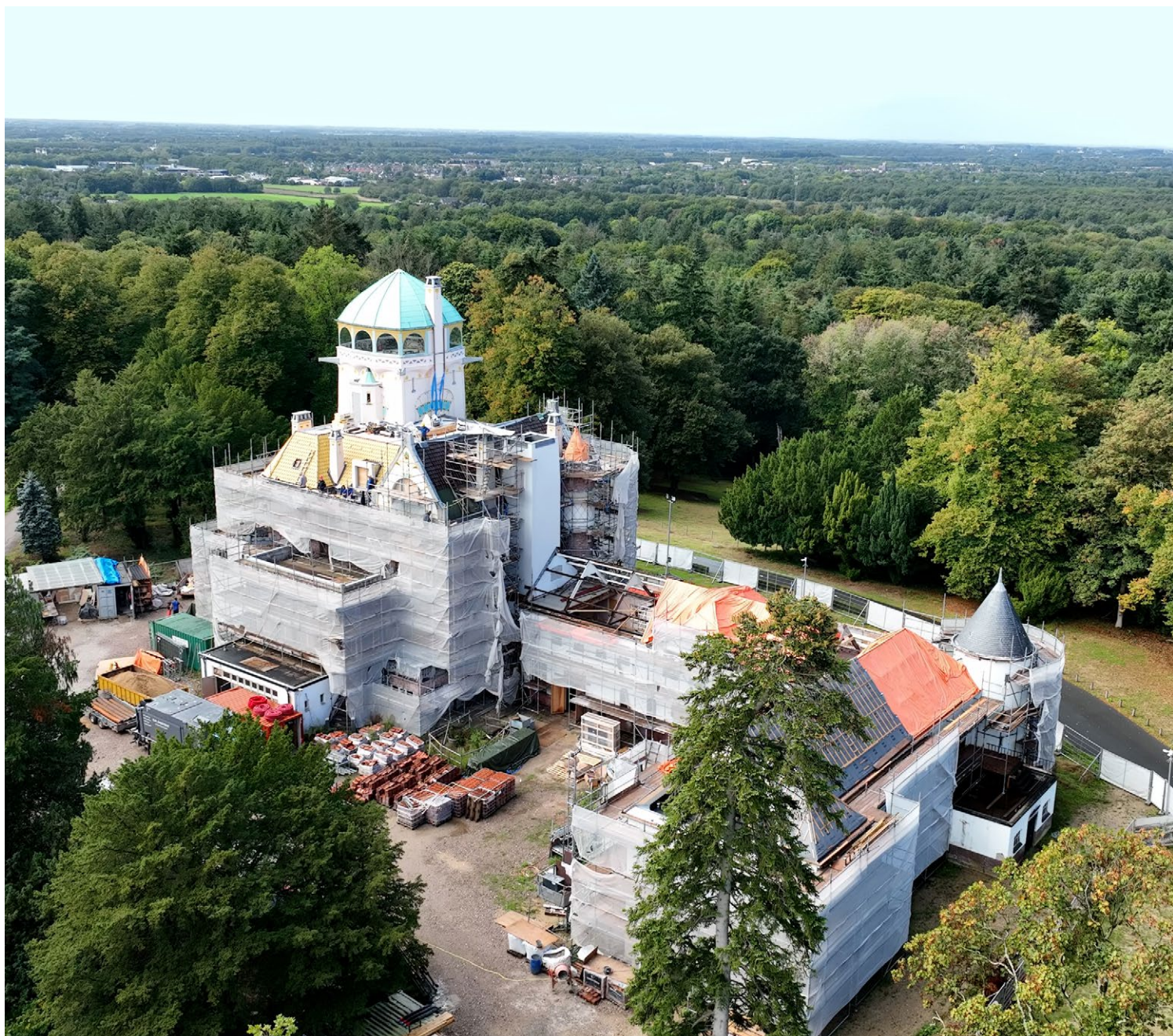
De restauratie van Jachtslot Mookerheide (Natuurmonumenten), waarbij het landhuis is hersteld in originele Jugendstijl, is mede mogelijk gemaakt met middelen uit de Subsidieregeling Restauratie Rijksmonumenten 2019-2020. Foto Van Dinther Bouwbedrijf bv.
