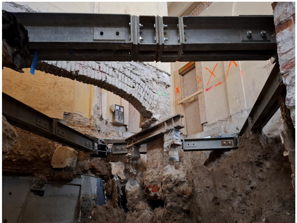
(Afbeelding 5: Nieuwe ondersteuning funderingen Eerste Kamer)
