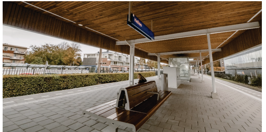
Station Heiloo met nieuwe duurzame perronkap.
