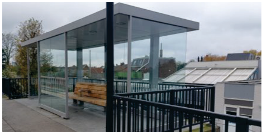
Station Tegelen: beschuttingssysteem
