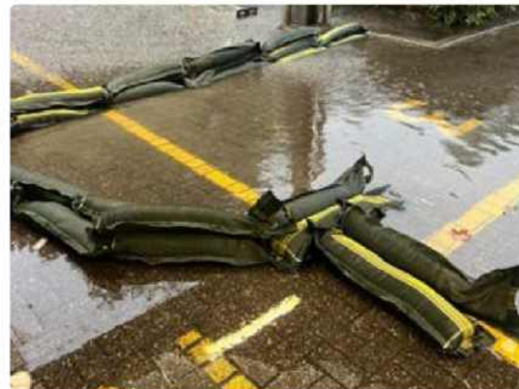
Figuur 18: Geplaatste zandzakken (bron: Slingeland.nl).
