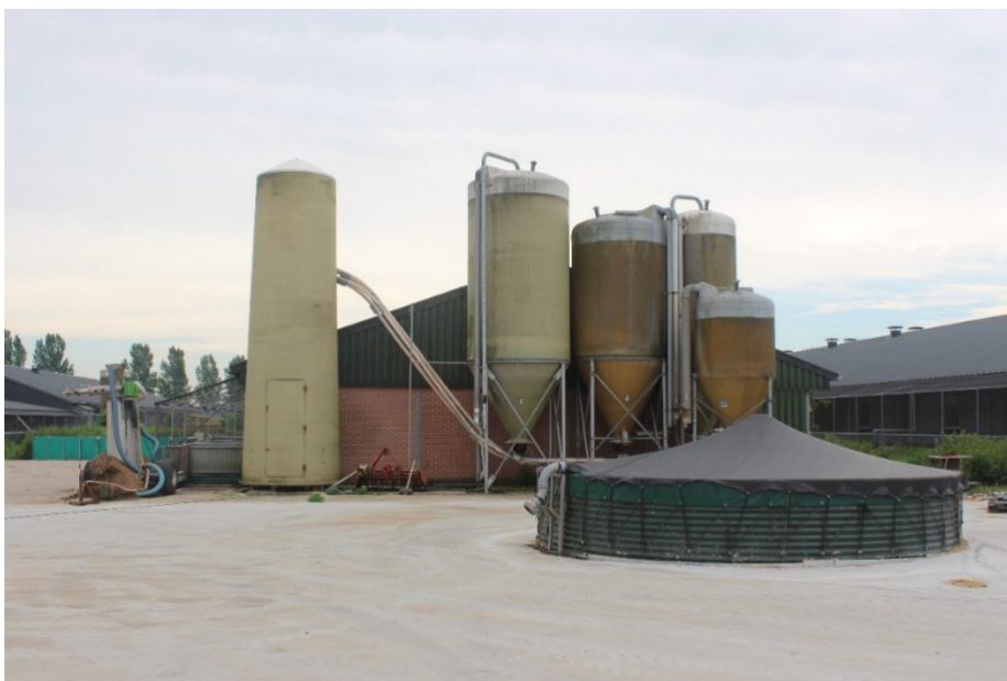
Figuur 2.19 Voersilo's en mestsilos op de voorgrond (Bron: Brandweeracademie)
