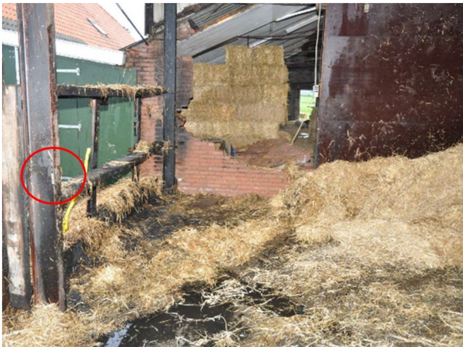
Figuur 2.2 Als gevolg van laswerkzaamheden zijn strobalen tot ontbranding gekomen (Bron: Team brandonderzoek Gelderland-Midden)
