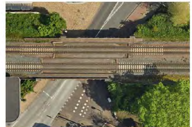
Figuur 4.4 dwangpunt spoorviaduct Velperweg met direct bevestigd spoor (links station Arnhem Velperpoort)
