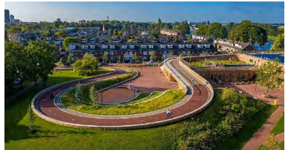
Fietspad met hoogteverschil, School Oog in Al, Utrecht
