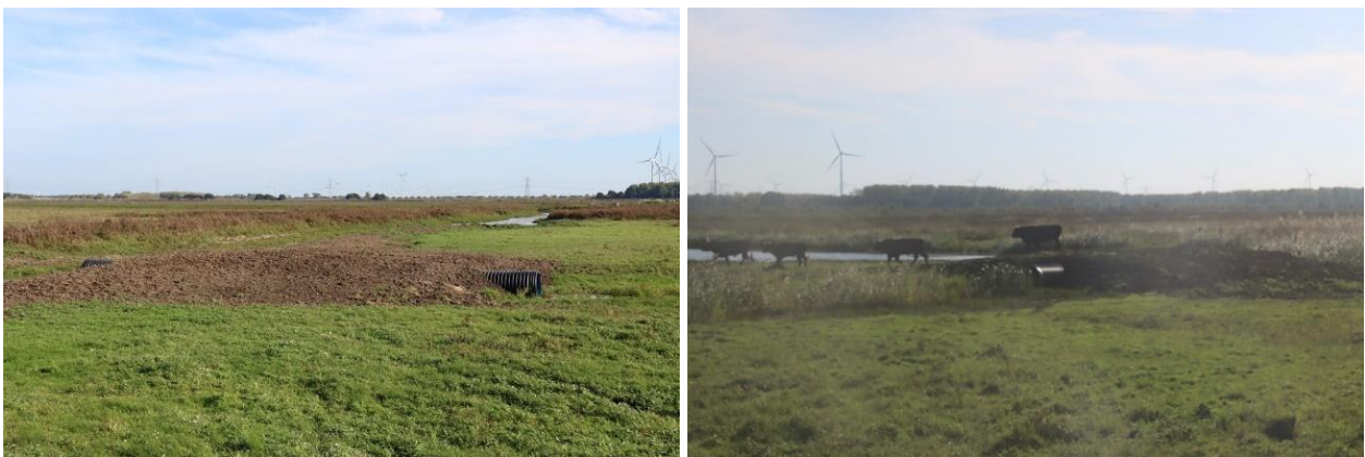
Figuur 35 Om te voorkomen dat in de winterperiode bij hoogwater de grote grazers worden ingesloten door het water, zijn er verschillende dammen met duikerbuizen gerealiseerd, zodat grote grazers de hogere delen (hoogwatervluchtplaatsen/hoogwatermigratieroutes) in het terrein kunnen bereiken bij hoogwater. Foto's: Fabrice Ottburg©.
