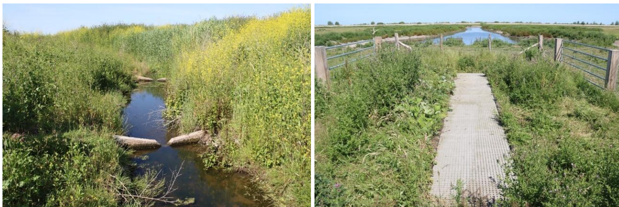
Figuur 20 Gerealiseerde ontsnipperingsmaatregelen ten behoeve van zoetwatervissen in het grazige gebied. Links de open in het landschap liggende vistrap en rechts een witvispassage (box-constructie). Beide elementen maken de uitwisseling mogelijk vanuit het achterland richting het rietmoeras. Foto's: Fabrice Ottburg®.
