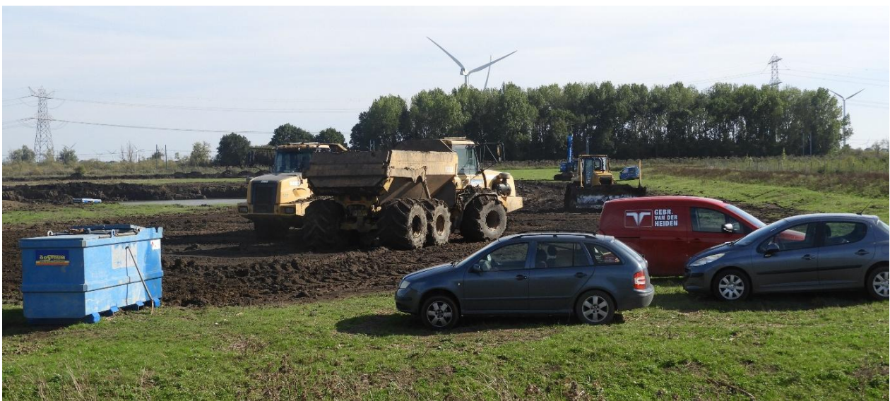
Figuur 45 Afgegraven van een perceel nabij de spoordijk, met het doel vernatting en vergroten van de landschappelijke variatie. Situatie in september 2025. Foto: Theo van der Sluis©.
