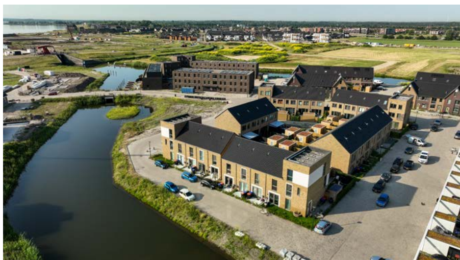
Foto: Heijmans Horizon woningen in Zeewolde.
