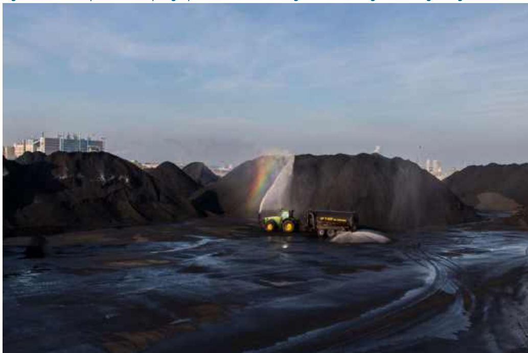
Figuur 6-2: Het besproeien van opslaghopen is een BBT-maatregel om verwaaiing van stof tegen te gaan
