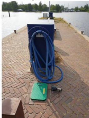
Vuilwaterafgiftepunt Earnewâld. Het groene deksel is voor de rondvaartschepen; de camlock koppeling female (zwart) ligt ernaast. De female zit aan het schip (schip is vrouwelijk), de male in de put. Blauwe slang en kast is voor de recreatievaart (zuigpomp).
