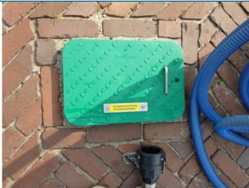
Vuilwaterafgiftepunt Earnewâld. Het groene deksel is voor de rondvaartschepen; de camlock koppeling female (zwart) ligt ernaast. De female zit aan het schip (schip is vrouwelijk), de male in de put. Blauwe slang en kast is voor de recreatievaart (zuigpomp).
