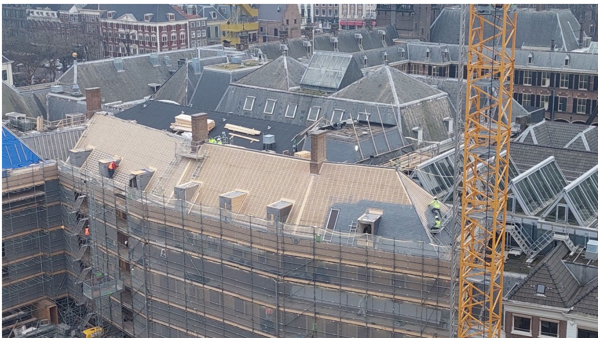
Werkzaamheden daken Tweede Kamer
