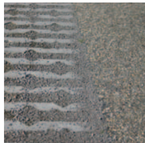
Duomix fundering onder grasbetonblokken
