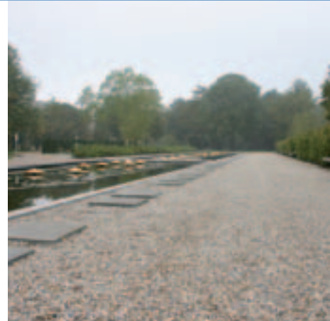
Duomix fundering onder granulaat paden
