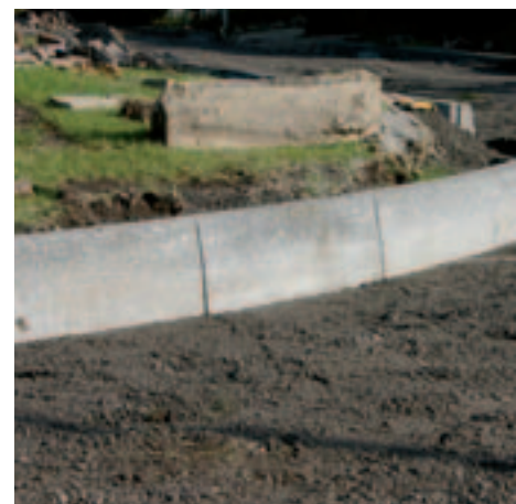
Stellen trottoirbanden in Duomix
