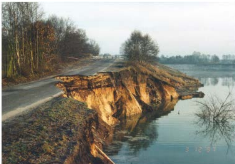
Figuur 1.1 Voorbeeld oeverval (bresvorming) bij een te stijl zand/grond talud, (Optimum, Informatiemagazine voor de GWW sector, Nr. 9, september 2002, blz. 6-9, onderzoek uitgevoerd door Deltares).
