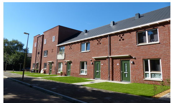
Afbeelding 1: Binnenhofjes fase 2 (Foto: Nijhuis Bouw)
